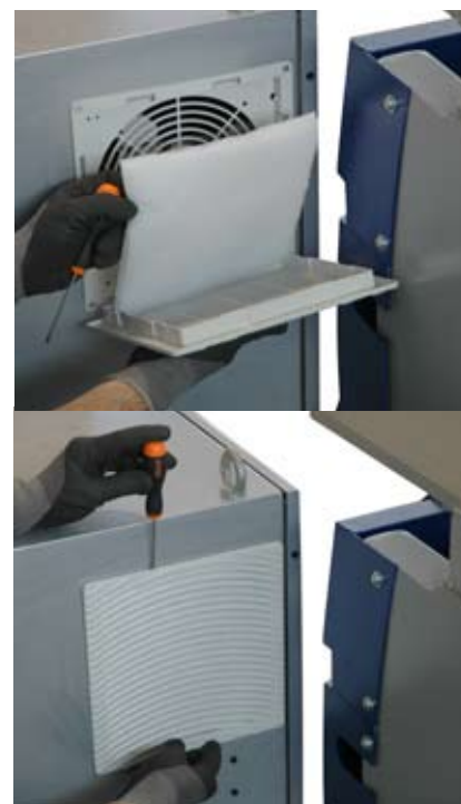
Рис. 39: Очистка электрических компонентов оборудования
